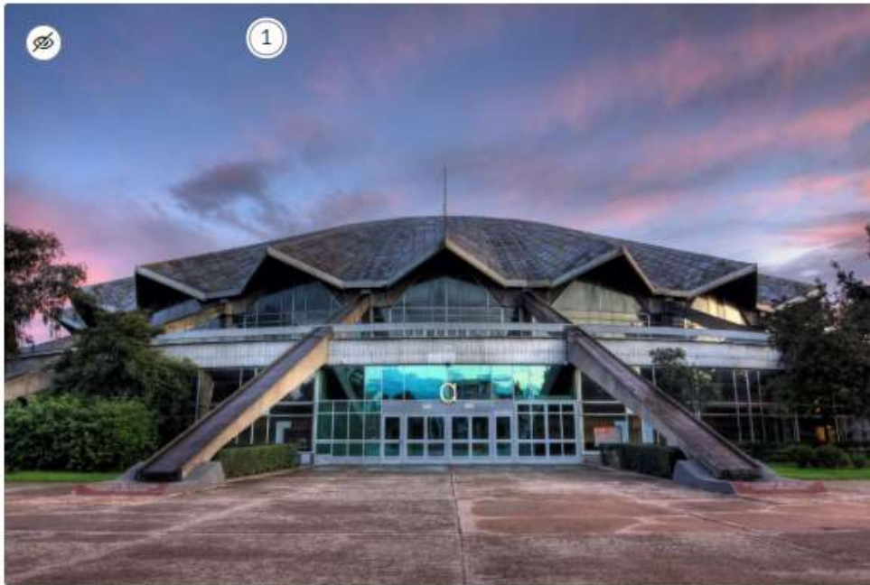
Konstrukttywizm, Jerzy Turzeniecki, „Hala widowiskowo-sportowa Arena”, 1972-1974, Poznań, Polska, upload.wikimedia.org
