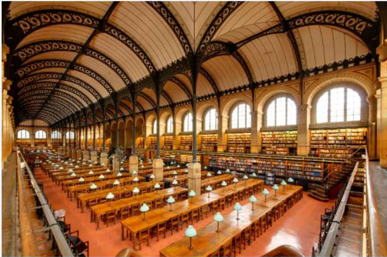
Biblioteka Sainte-Geneviève w Paryżu, 1843-1850 (Henri Labrouste), historyzująca fasada i żeliwna konstrukcja sklepienia czytelní, wikimedia.org, CC BY-SA 2.0
